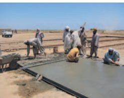
Entstehung eines Betonwerkes in Shamali
